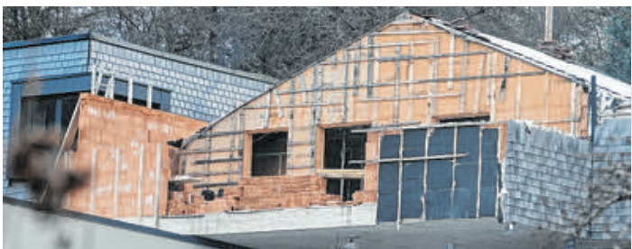
Das juristische Tauziehen um das Haus am Landecker Hasliweg ist zu Ende. Der Bauwerber will es mit den nötigen Adaptierungen fertigstellen. Wenzel
